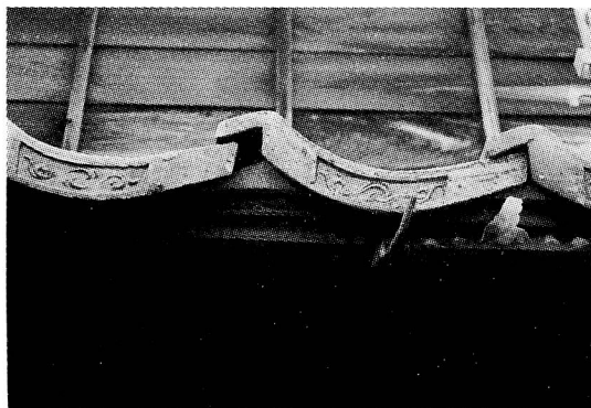
前庇の瓦部分 面戸瓦がみえる
