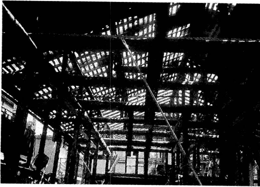
図5 野地板が撤去され光が射し込む
