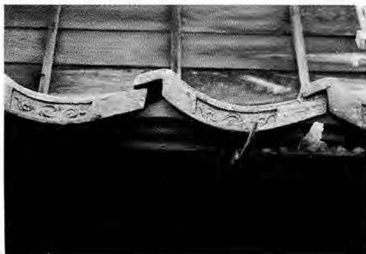
前庇の瓦部分 面戸瓦がみえる
