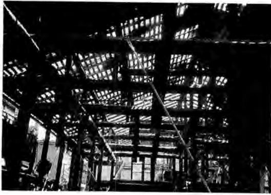
図5 野地板が撤去され光が射し込む
