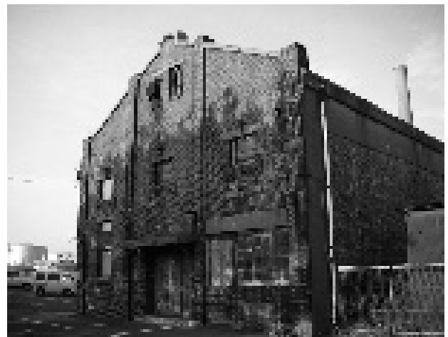
沼垂日石の赤煉瓦倉庫
