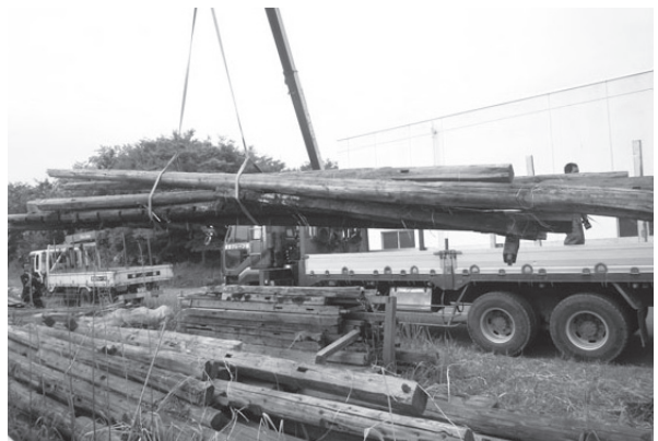
部材を移転する現場
