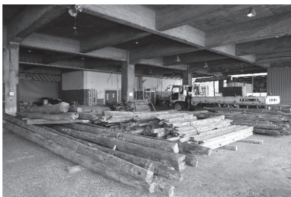
万代島の旧水揚げ場に搬入された解体部材。
